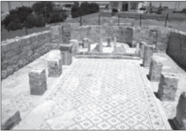
٣. منظر عام لأروقة وهيكل كنيسة جورجوس / رحاب بعد الترميم.
